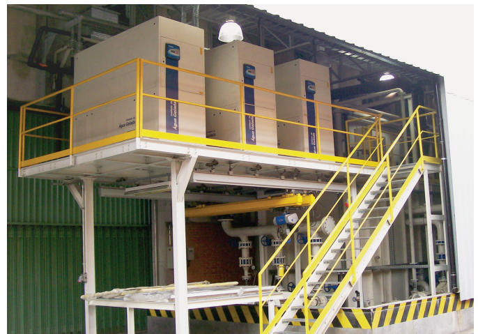
CENTRAL DE REFRIGERAÇÃO COOLING CENTER
